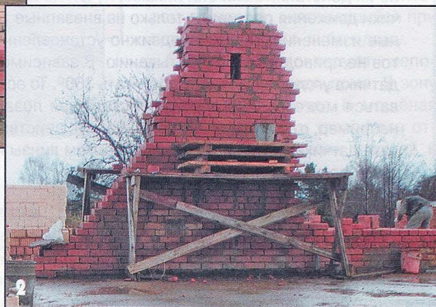
Мастер-печник выкладывает внутреннюю стену-перегородку. Труба из нержавеющей стали завернута в базальтовый картон и установлена в кладке.
