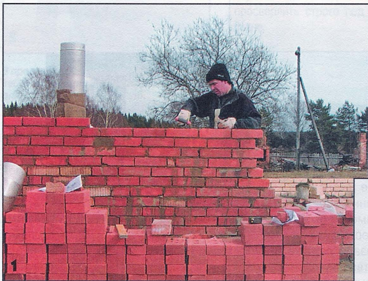
Мастер-печник выкладывает внутреннюю стену-перегородку. Труба из нержавеющей стали завернута в базальтовый картон и установлена в кладке.
